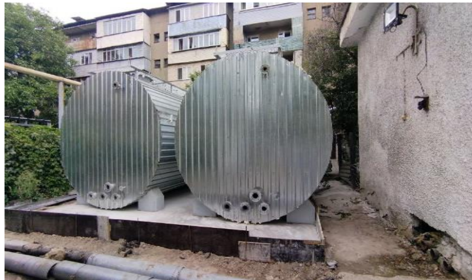
Аккумуляторный бак, объем 20 м3 и 25 м3 горизонтальный ТП Суюнбая, ТП Комета
