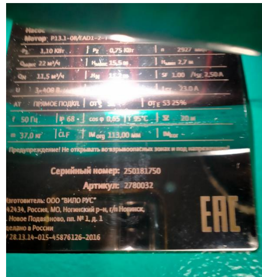
4. Погружной дренажный насос, Номинальная подача не менее, м 3 /ч- 10; Номинальный напор не менее, м - 10.
